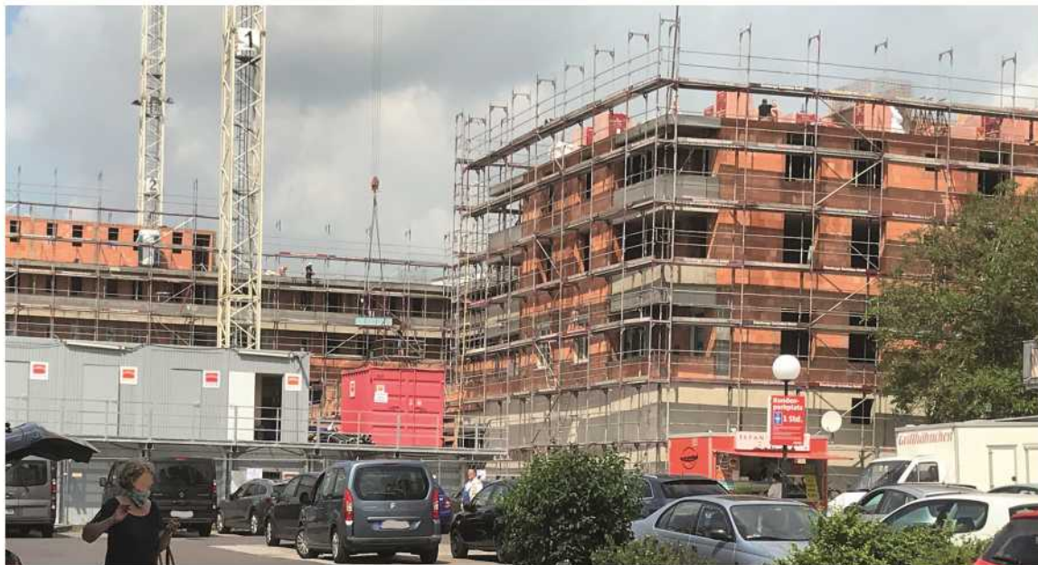
Bild 157: Der Neubau des Wohn- und Geschäftsgebäudes „Panoramablick“ schreitet zügig voran (Aufnahme vom Juni 2020)
