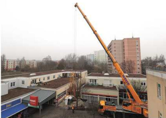
Bilder 147/148: Die Aufstockung der Häuser an der Marcel-Paul-Straße 48A bis 48C im Jahre 2018 - Aufstellung des Baukranes (oben), Richtfest (unten)
