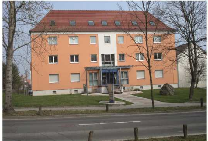
Bild 57: Die Geschäftsstelle der Gemeinnützigen Wohnungsgenossenschaft e.G. in der Ettersburger Straße
