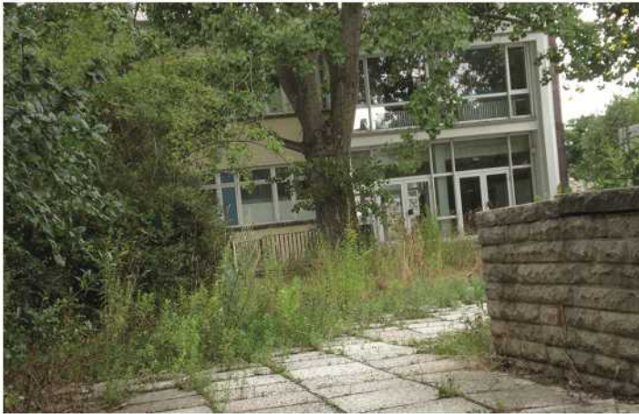
Bild 64: Die „Redoute“ vor der Sanierung
