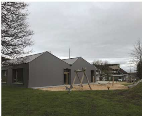
Bilder 144/145: Der neue Betriebskindergarten an der Straße des 17. Juni während des Baus (Bild oben) und nach Fertigstellung (Bild unten)
