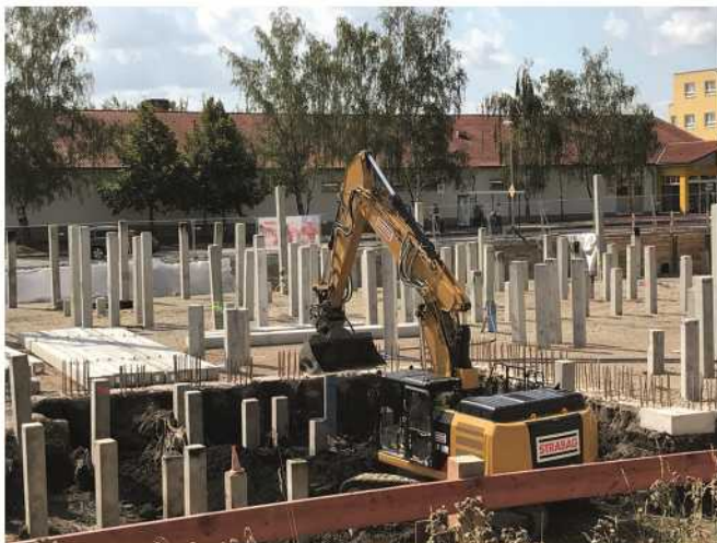
Bild 155/156: Im Baustellenbereich des Wohn- und Geschäftsgebäudes „Panoramablick“ werden mächtige Rammpfähle in den Boden getrieben
