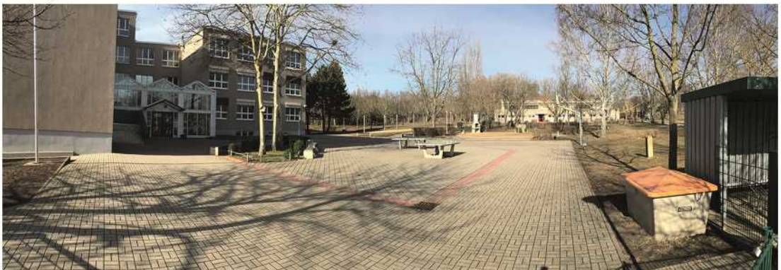
Bild 102: Die Herderschule nach ihrer Sanierung 2011
