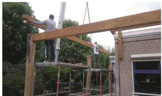
Bild 16: Die Arbeit am Terrassendach schreitet voran
