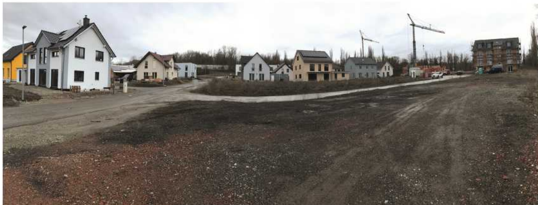
Bild 122: Das neue Wohnungsbaugelände Lützendorfer Straße/ Umgehungsstraße im Dezember 2019
